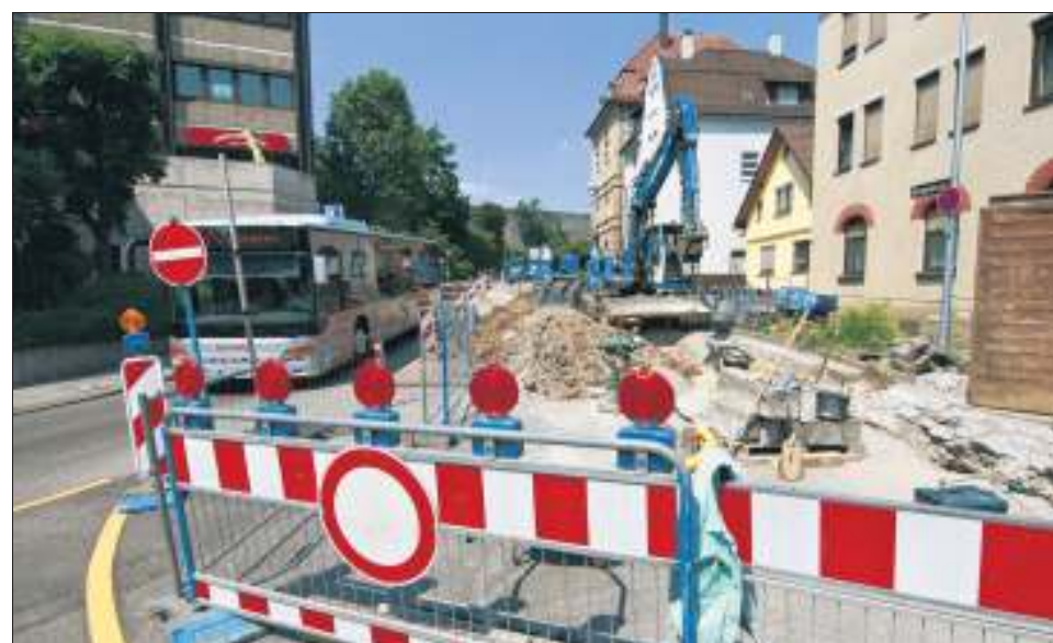
Auf einer Länge von insgesamt 135 Metern werden die Rohre ersetzt.
